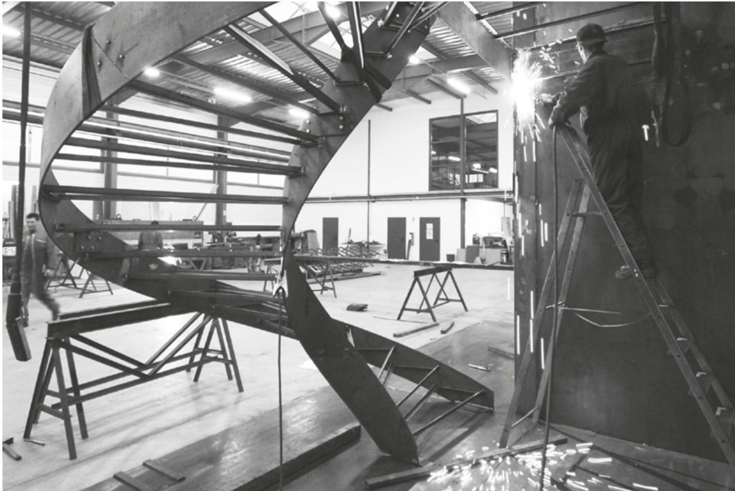
Escaliers métalliques et métallerie sur-mesure
